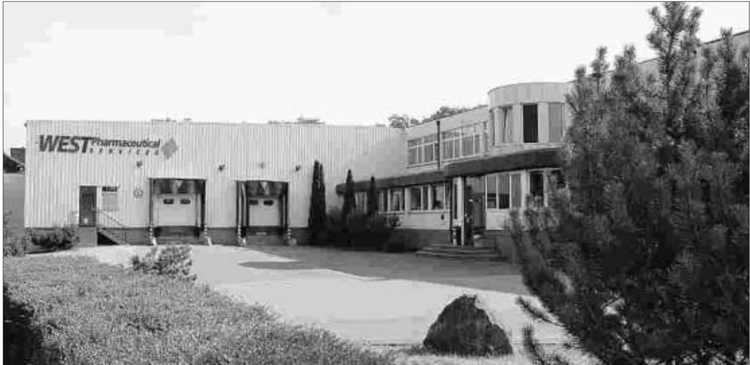
So kennen die Indestädter das Werk an der Stolberger Straße: der Eingangsbereich zur Westpharma-Europazentrale. Hier stellt Westpharma jetzt 30 bis 40 zusätzliche Mitarbeiter ein. Fotos: Rudolf Müller
