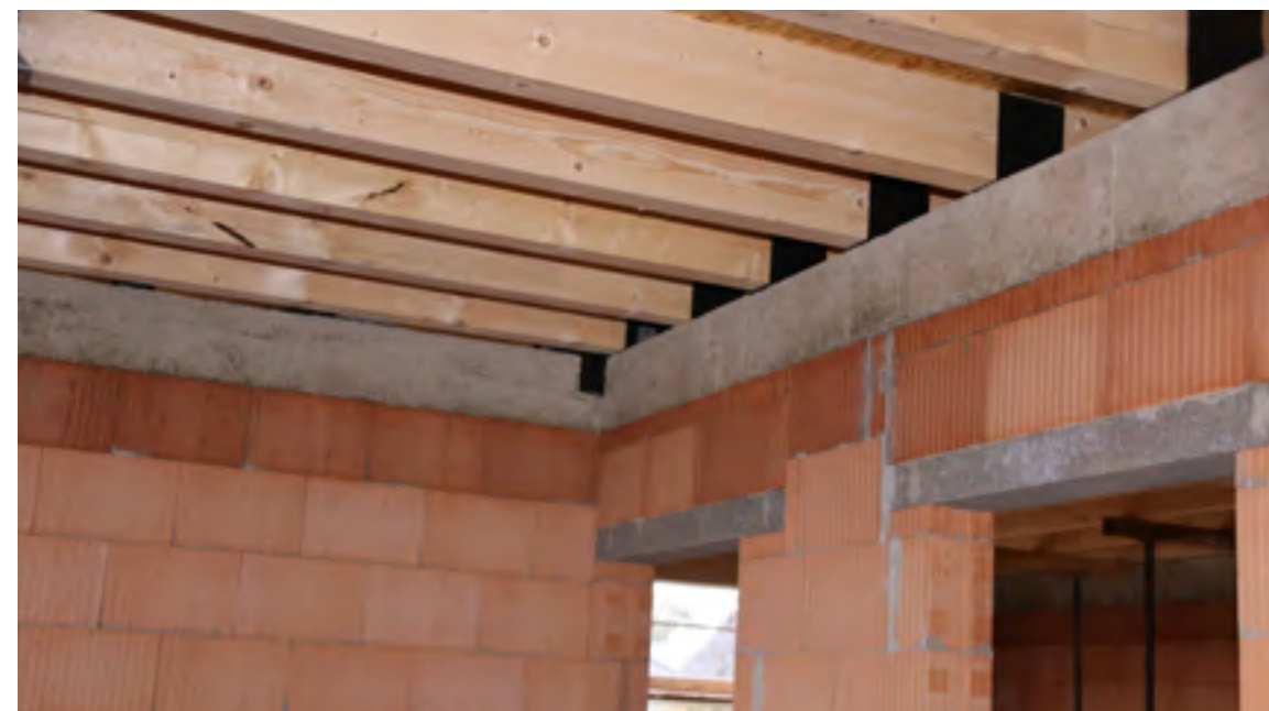
Abb. 15 - Holzbalkendecke im Massivbau
