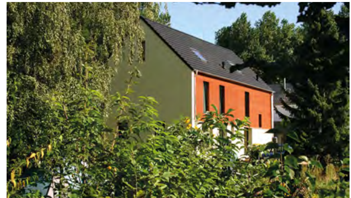
Abb. 25 - Einfache rechteckige Hausform mit geringem Dachüberstand
