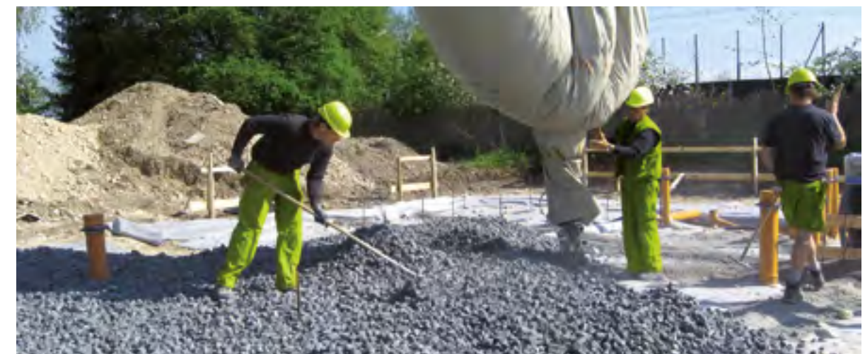
Abb. 27 - Das Einbringen von Glasschaumschotter ist besonders einfach, er wird auf ein Geotextil geschüttet und anschließend maschinell verdichtet.
