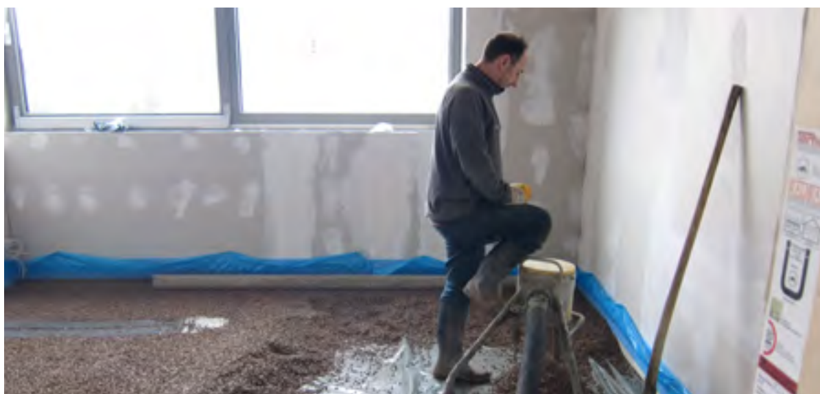
Abb. 35 - Einbau einer elastischen Schüttung im Faktor 4 Haus in Inden.
