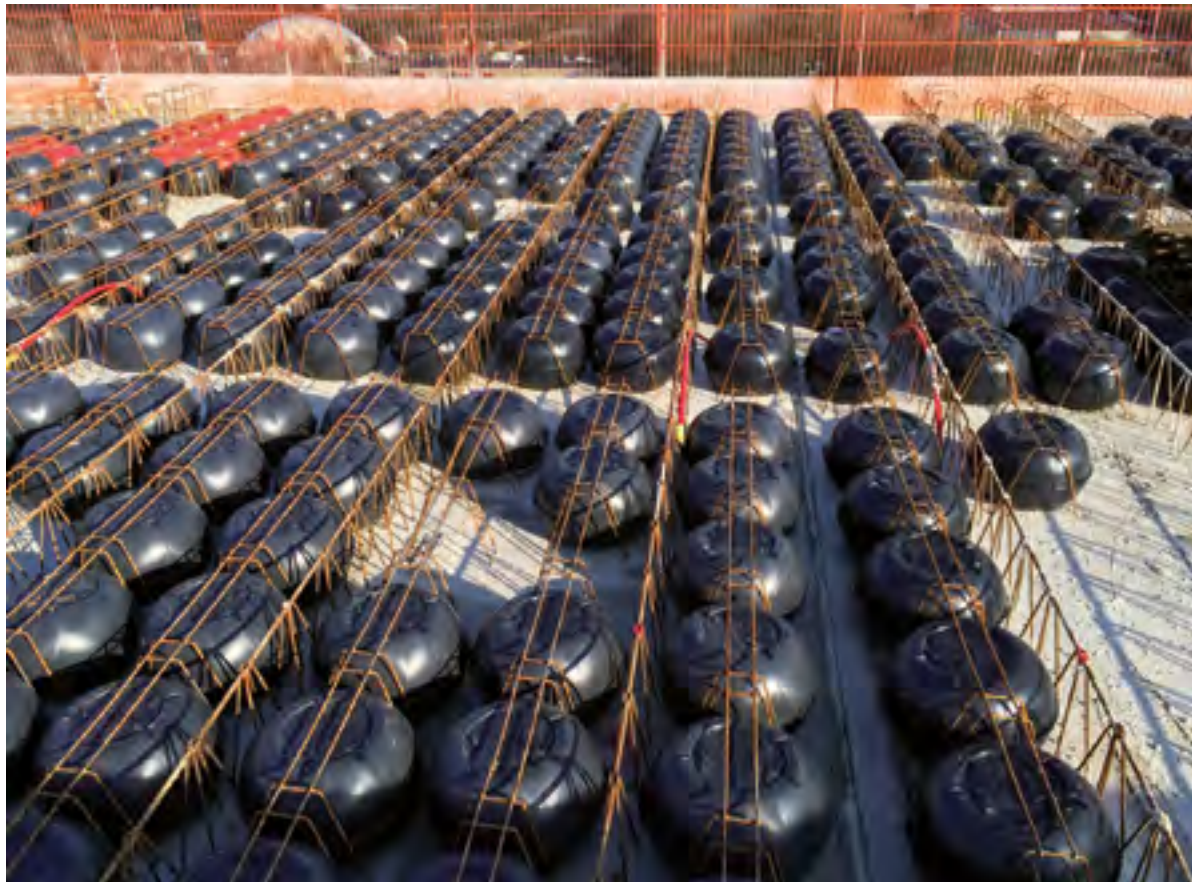
Abb. 12 - Die Cobiax Betondecke spart Beton an den Stellen, wo er statisch nicht benötigt wird.
