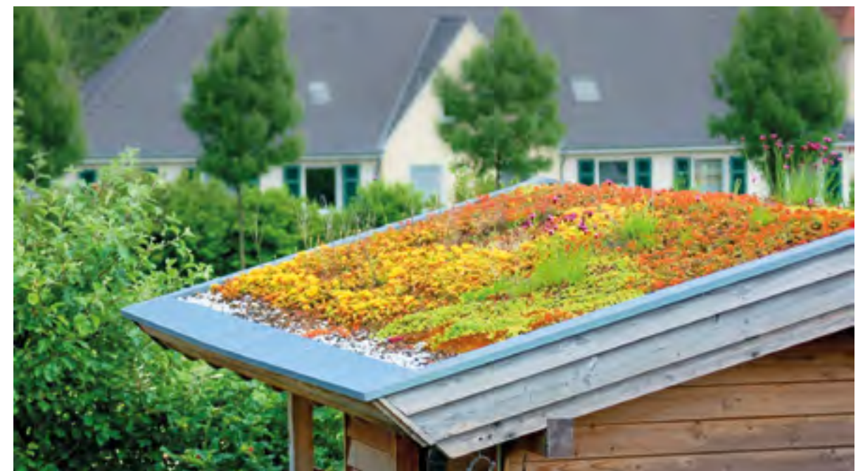
Abb. 36 - Gründach auf einem Nebengebäude
