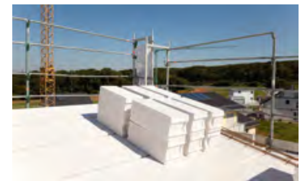
Abb. 34 - Eine Fertigteildecke aus Porenbeton kann eine Betondecke ressourcensparend ersetzen.
