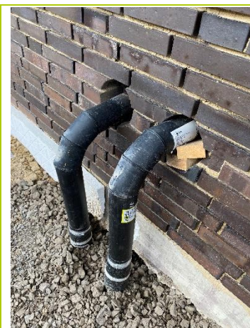
Abbildung 11: Rohre noch ohne Verkleidung
