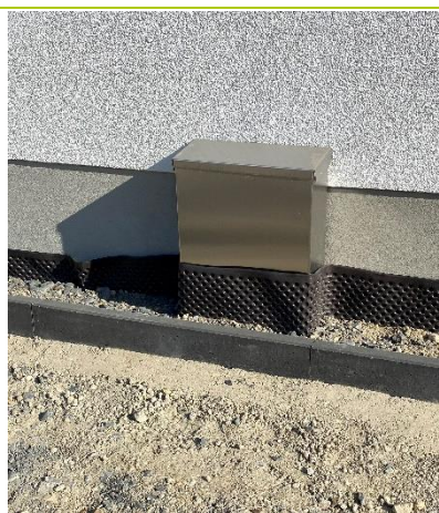
Abbildung 10: Abkastung aus Edelstahlblech
