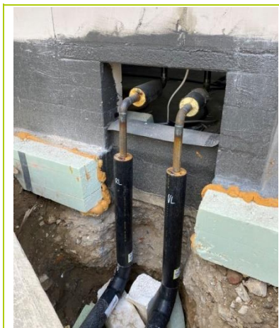
Abbildung 9: Mauerwerk ausgeklinkt, Rohre werden überputzt
